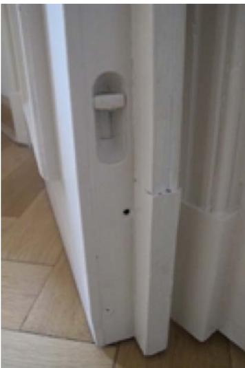
Merke: Der Kantenriegel ist der seitlich in das Rahmenholz eingelassene Metallriegel, der bei einer Doppelflügeltür (oder Doppelflügel fenster) einen Flügel fest arretiert.
